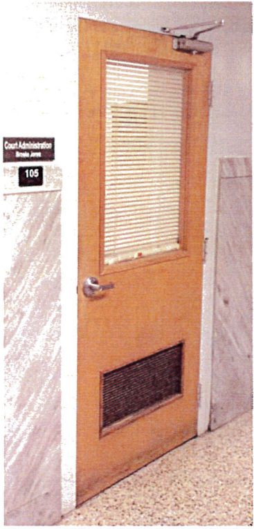
First floor hallway door
