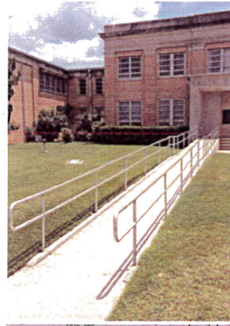
ADA handicap ramp
