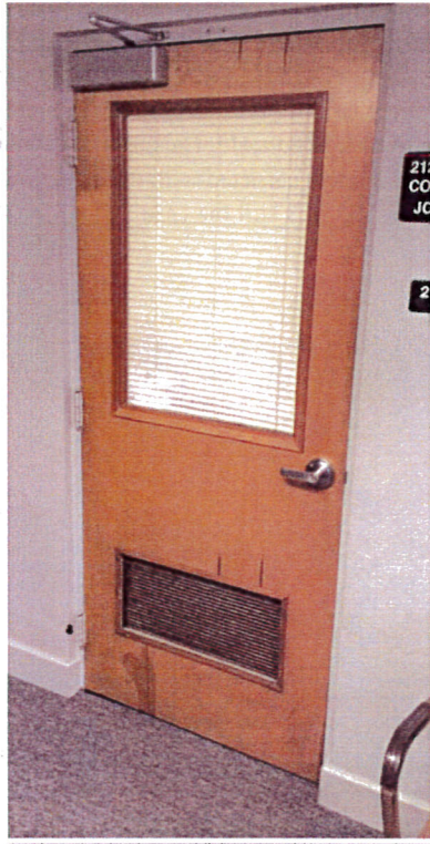
Second floor hallway door
