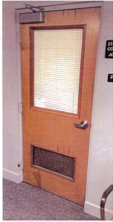
Second floor hallway door
