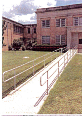
ADA handicap ramp
